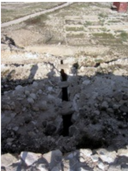
Abb. 19 Der Kanal, durch den Wasser unter der Mauer in die Zisterne der Festung geleitet wurde.
