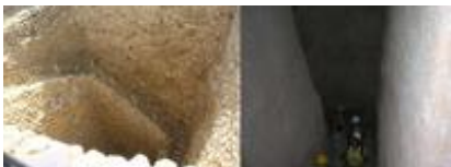
Abb. 5 Das Zisternensystem von Tell es-Seba' wird vom nahen Wadi gespeist und ist über einen Schacht erreichbar.
