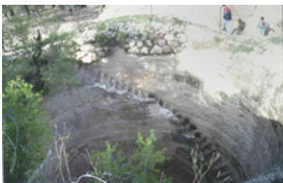
Abb. 9 Ein Schacht mit Treppe und Brüstung bildet einen Zugang zum Wasser.
