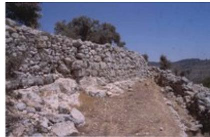
13 x 4,5-5m) umgeben, von denen zumindest Turm 2 auch als Stadttor diente. Verwendet wurden für die Bauten geringfügig behauene, zum Teil in Läufer-Binder-Technik gesetzte Quadersteine. Die Mauer ist über weite Strecken nicht nur gut sichtbar, sondern steht noch bis zu 2,5m hoch an – allerdings ist sie im Zuge neuzeitlicher militärischer Befestigungen, zu denen auch parallel verlaufende Schützengräben gehören, stellenweise ausgebessert und erhöht worden.
