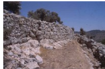
Abb. 4 Abschnitt der Mauer der Unterstadt von Chirbet Kefire (Eisenzeit II).
