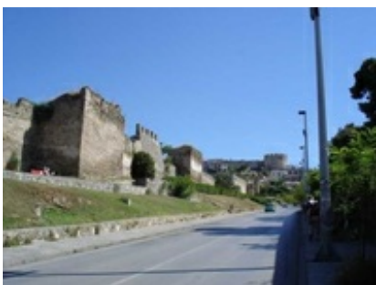
Abb. 21 Nordostmauer mit Trigoniou-Turm im Hintergrund.
